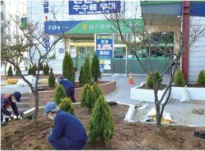
날짜: 22.3.29. 내용: 원예농협하나로마트 앞 조경 식재
